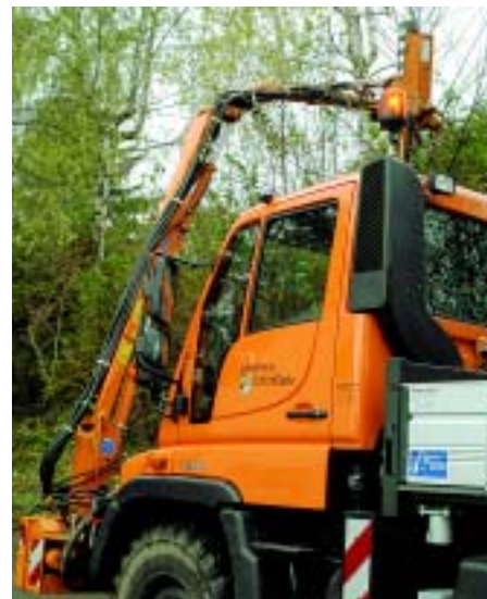
Die beiden U 400 bei Astfreischneide- und Mäharbeiten
